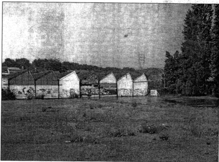
Parmi les 5 zones qui doivent faire l'objet d'une rénovation urbaine, il y a l'espace Hayeneux, situé entre les rues Haute Marexhe et Hayeneux. L'objectif est de commencer par ce site, censé faire tache d'huile. (DEVOGHEL)
