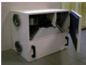
Figuur 2: “CLI 380 DF” ventilatiegroep voor balansventilatie - extractie en pulsie (systeem D)
