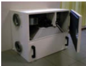
Fig. 2: "CLI 380 DF" - Groupe de ventilation pour ventilation équilibrée – extraction et pulsion (système D)
