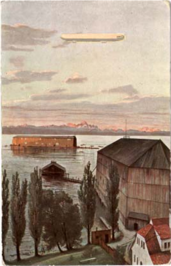
Zeppelinhallen waren van bij het begin staaltjes van ingenieurskunst, zoals de eerste drijvende hallen op de Bodensee anno 1900-1908 (linksboven en -onder), of de eerste hal op vaste bodem in de thuis-haven van de firma Zeppelin, Friedrichshafen (Zuid-Duitsland) uit 1909 (onder)
